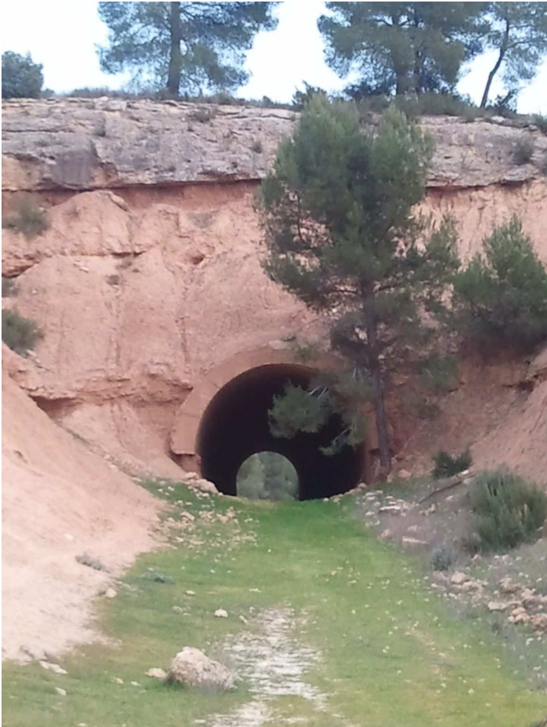
Túnel del Utiel-Baeza en la Derrubiada (Peñón Hundido-Hoya Quemada en Venta del Moro)
