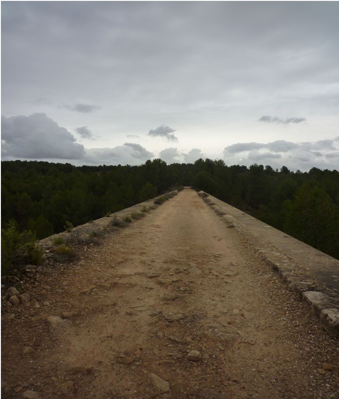
Puente del Utiel-Baeza que salva el barranco Varejo (Venta del Moro)
